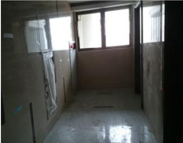
A6 區 F 棟梯廳施作
