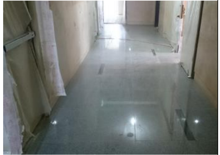
A6 區 C 棟梯廳施作
