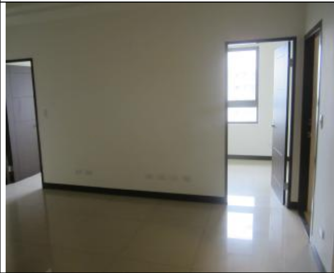
A6 東區 I 棟現況
