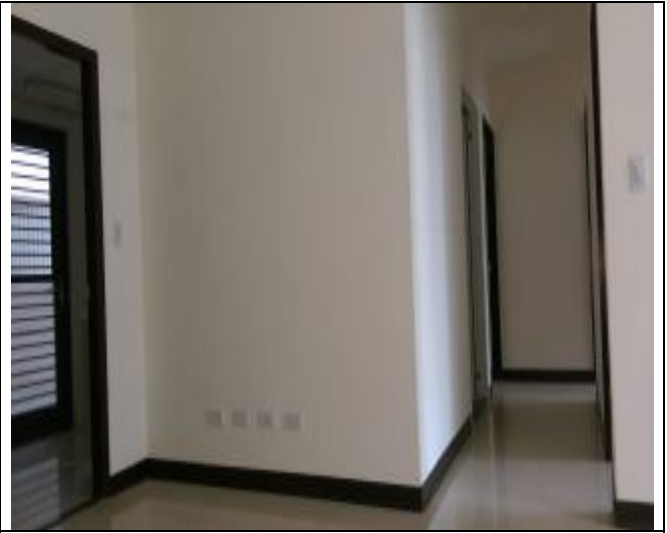
A6 東區 H 棟現況
