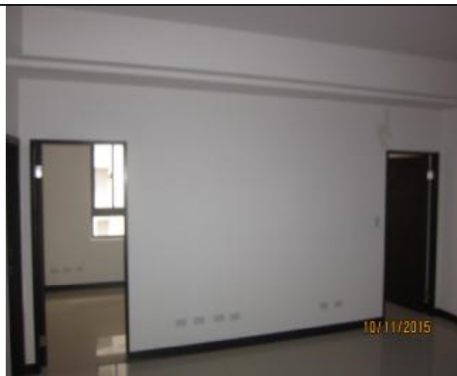
A3 區 F 棟現況
