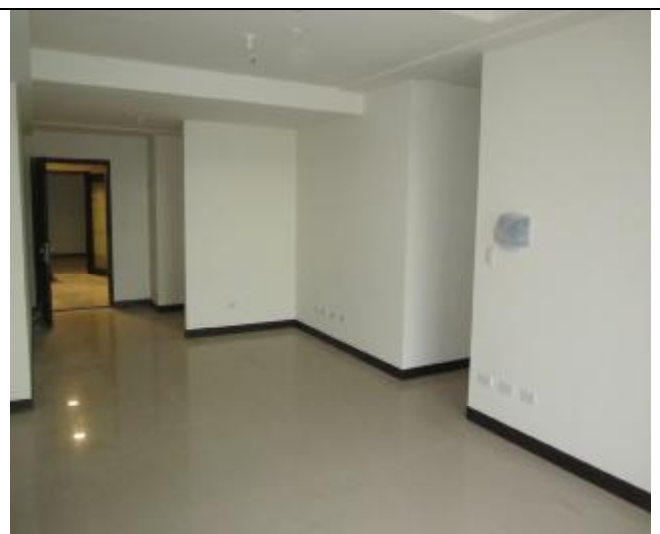
A6 西區 V 棟現況
