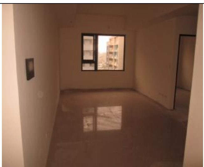
A6 西區 R 棟現況
