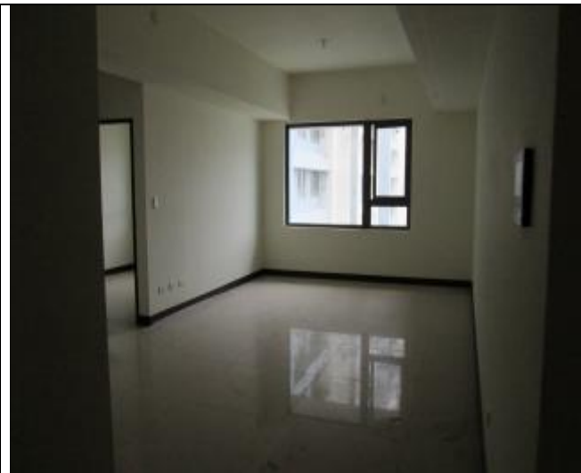
A6 西區 K 棟現況
