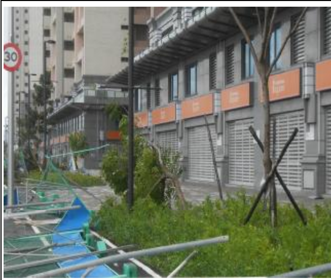
杜鵑颱風侵襲施工圍籬倒塌
