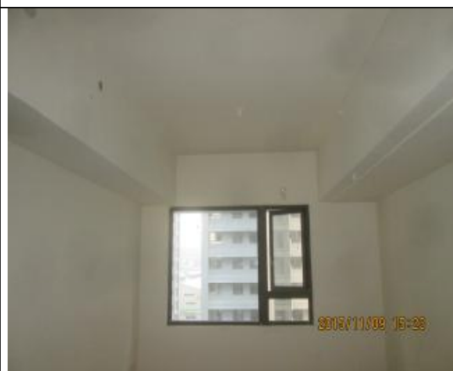
A6 西區 O 棟現況
