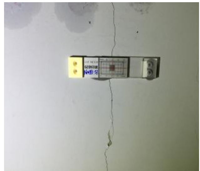
地震後裂縫計查勘(A6區地下室)
