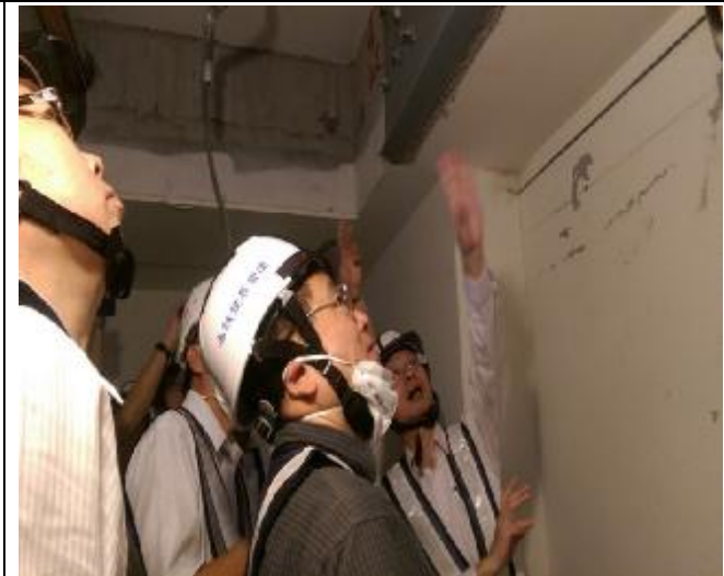
照片 4：A3 南區 H 棟 4 樓連梁補強施作現場勘查
