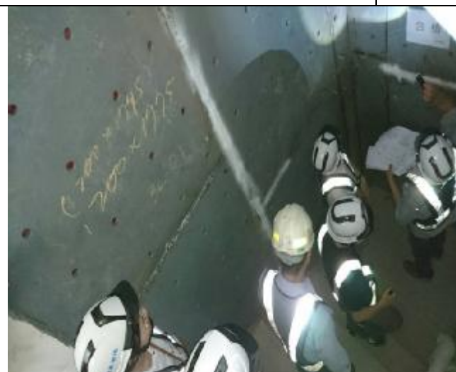
照片 12:A3 北區 B 棟樓梯間鋼鈹補強 施作現場勘查
