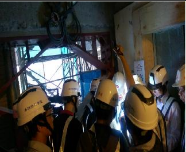
照片 3：A3 南區 H 棟 4 樓菱形鋼框施作現場勘查
