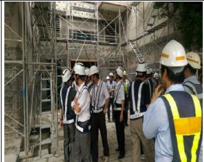
照片 6：A3 南區 H 棟 1 樓柱及構架梁補強施作現場勘查
