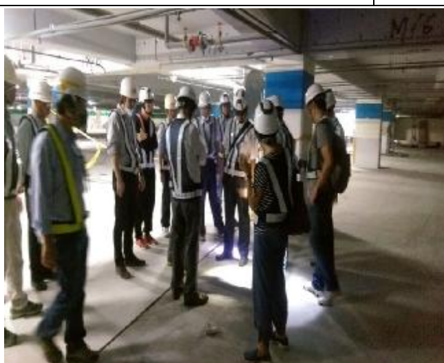
照片 10:A3 南區地下 3 樓地梁上層破 纖維施作現場勘查
