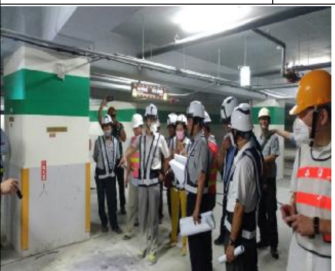
照片 11:A3 北區地下 3 樓地梁上層 破纖維施作現場勘查
