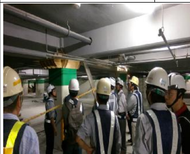
照片 9:A3 南區地下 2 樓梁柱接頭鋼 板補強施作現場勘查
