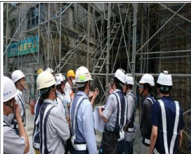
照片 7:A3 北區 B 棟 1 樓柱箍補強施 作現場勘查
