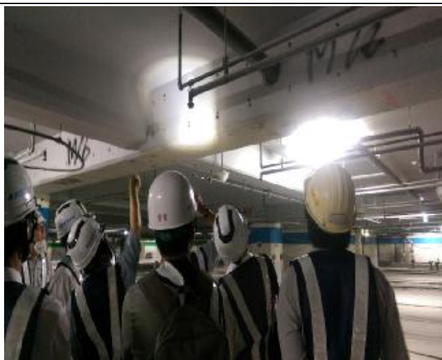
照片 8:A3 南區地下 2 樓梁下層鋼鈹 補強施作現場勘查
