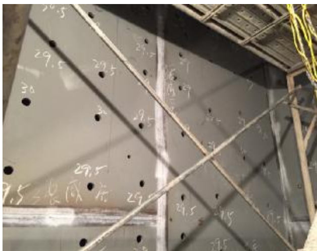
照片 17: 本公司抽查電梯井補強鋼鉸 鑽孔
