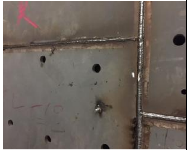
照片 16: 本公司抽查樓梯間鋼鉸補強鉸 道
