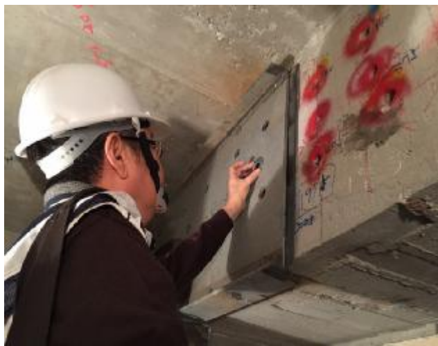
照片 9：營建署第二次臨時工程查核 A3C 棟 3F 梯廳連梁螺栓墊片檢視現勘 1051109
