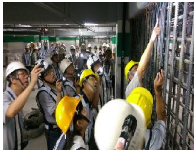
照片 5：第二次工程查核 A3 北區地下室剪力牆灌漿前施工檢視
