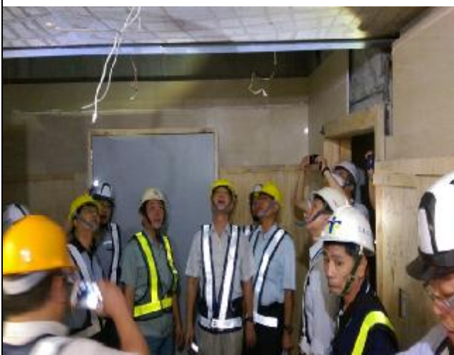
照片 3：第二次工程查核 A3 區梯廳連梁鑽孔施工檢視
