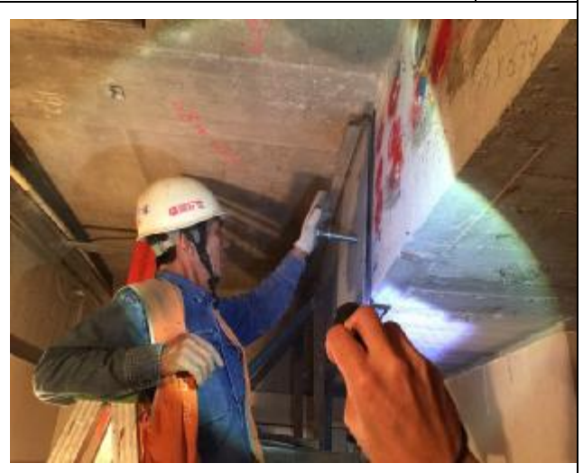
照片 12：營建署第二次臨時工程查核 A3C 棟 3F 梯廳連梁鑽孔位檢視現勘 1051109
