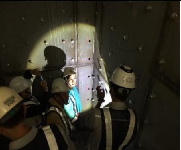
照片 11：營建署第二次臨時工程查核 A3F 棟 3F 樓梯間鋼板補強現勘 1051109
