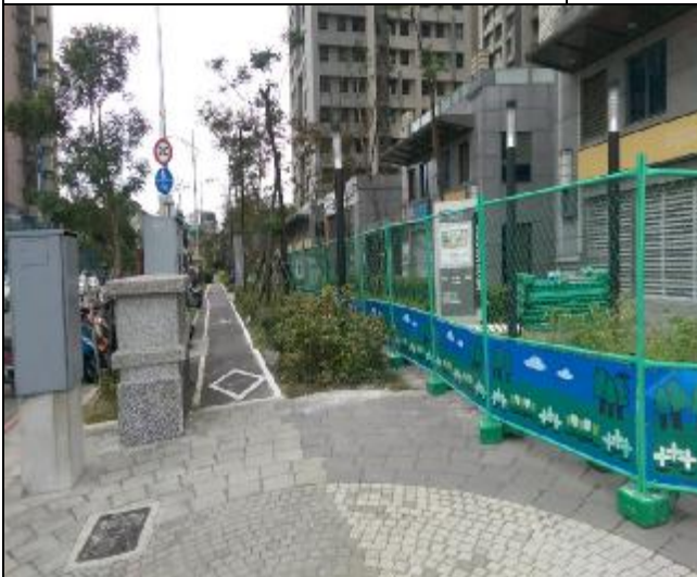
照片 11：本公司現地督導 A2 區施工臨時圍籬架設
