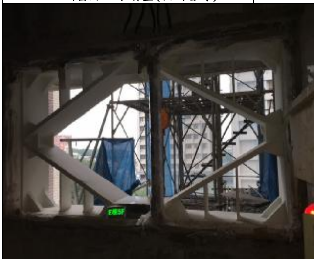
照片 17：本公司查證 A3 區 E 棟 5 樓菱形 鋼窗防火漆噴塗
