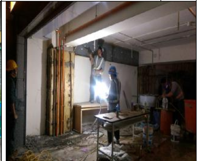
照片 12：本公司現地督導 A3 南區 H 棟 1F 柱補強無收縮水泥夜間灌漿作業
