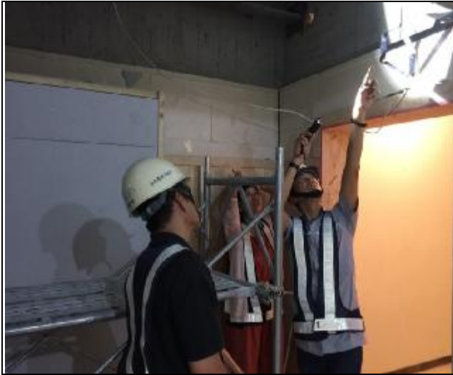
照片 7：營建署工地督導
