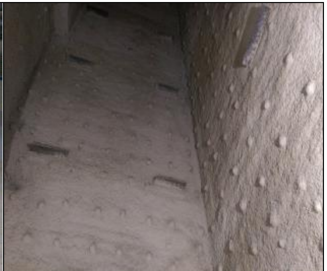
照片 14：本公司查證 A3 區 H 棟 10 樓 電梯昇降道鋼版補強後防火 披覆施作完成現況
