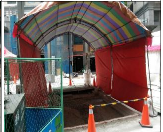
照片 10：本公司現地督導 A3 南區 1 樓中庭樓版補強之防護措施
