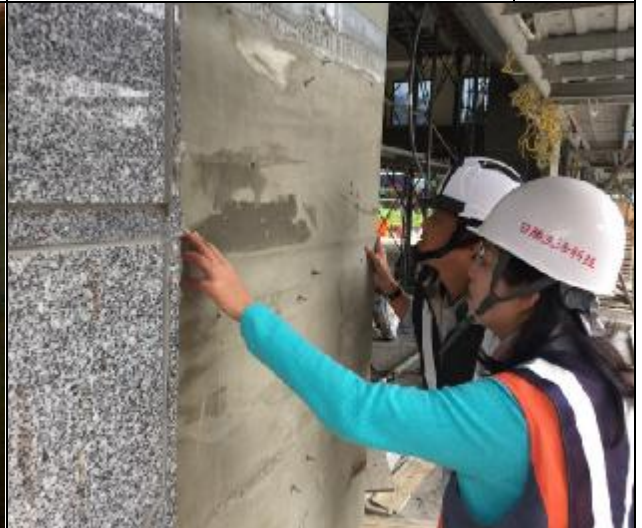
照片 16：營建署工地督導
