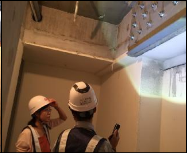
照片 8：營建署工地督導
