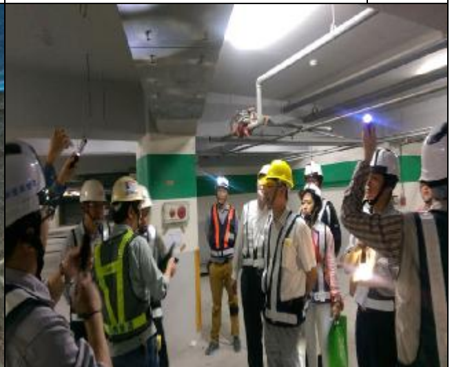
照片 4：第三次工程查核 A3 北區地下室梁鋼版補強施工檢視
