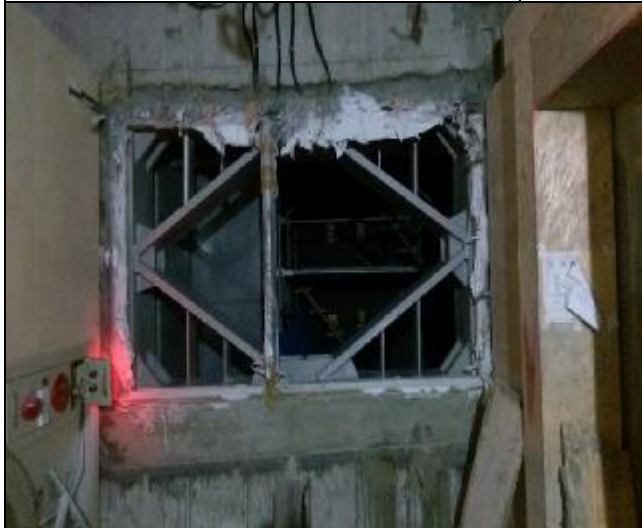
照片 15：本公司查證 A3 區 C 棟 3 樓菱形 鋼窗防火漆噴塗(夜間督導)
