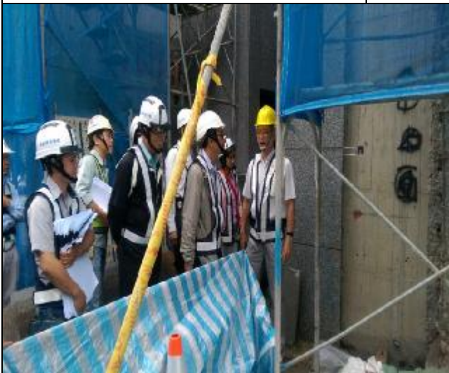
照片 3：第三次工程查核 A3 區 A 棟 1 樓施工檢視
