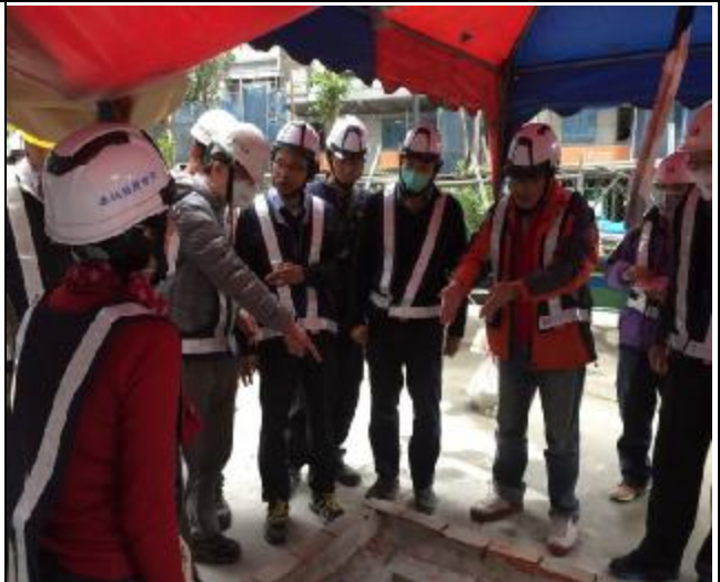
結構補強修繕第四次工程查核現場勘 查(A3 北區)
