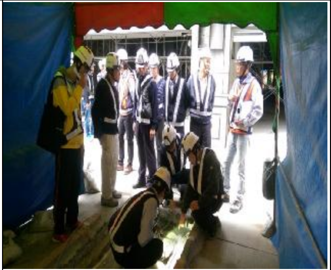
結構補強修繕第四次工程查核現場勘 查(A3 南區)
