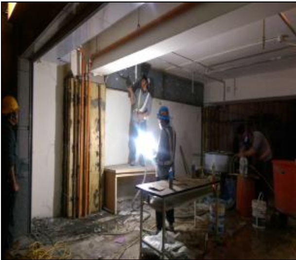
A3區H棟1樓夜間無收縮水泥灌漿督導 1051209
