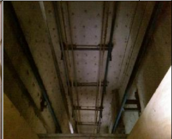
A3 區結構補強修繕工程竣工查驗(地上層，電梯管道補強完成)
