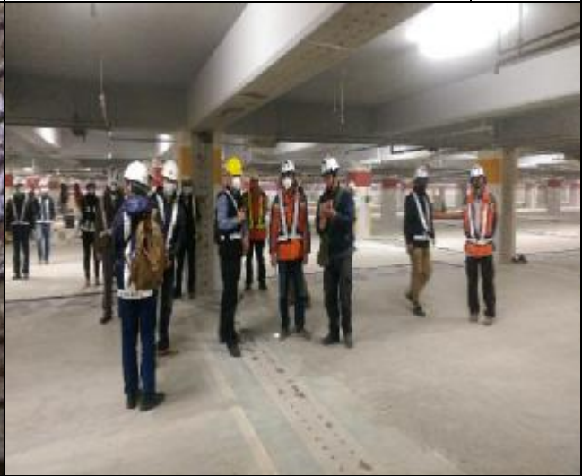
結構補強修繕第五次工程查核現場勘 查(A6 西區地下室)
