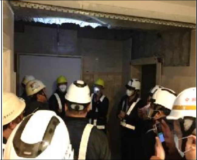
結構補強修繕第五次工程查核現場勘 查(A6 東區地上層梯廳連梁)
