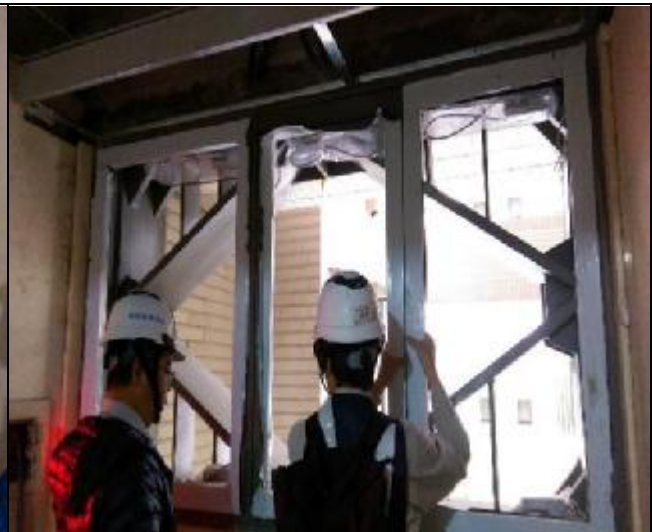
A3 區結構補強修繕工程竣工查驗(地上層，鋼框菱形斜撐)
