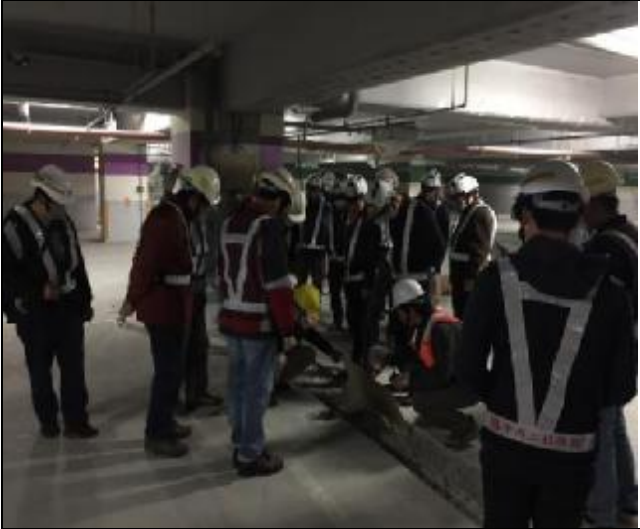
結構補強修繕第五次工程查核現場勘 查(A6 東區地下室)
