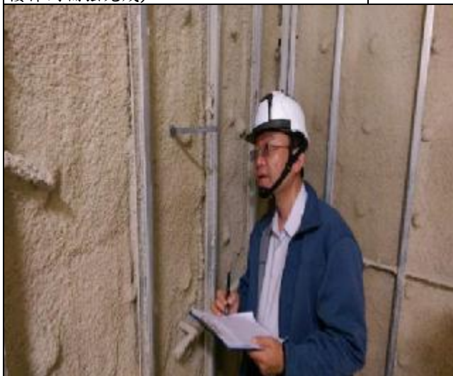
A3 區結構補強修繕工程防火披覆厚度抽查
