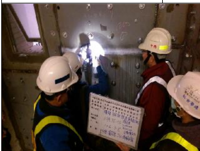
A6區A棟5樓樓梯鋼版銲道檢驗(磁粉探傷) 1060308
