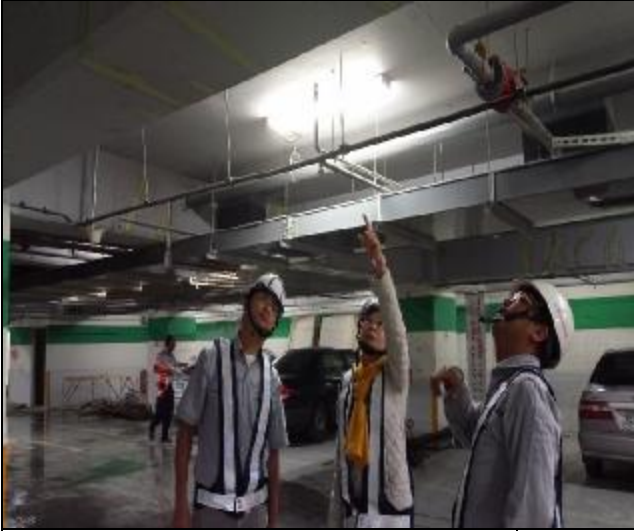
營建署臨時工程督導(A2 區地下室) 1060321
