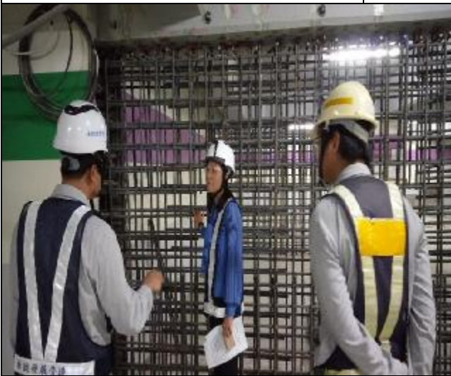
營建署臨時工程督導(A6 東區地下室) 1060329
