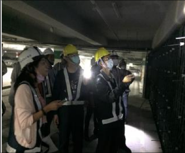
第七次結構補強修繕工程查核(現場 勘查)
