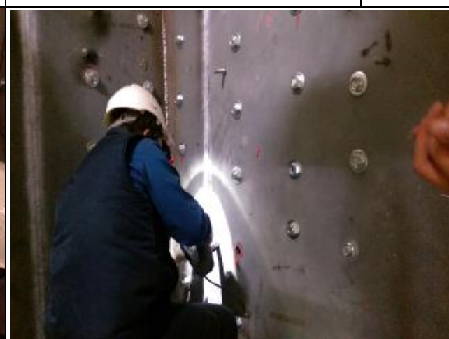
A2區C棟5樓樓梯鋼版銲道檢驗(磁粉探傷) 1060308
