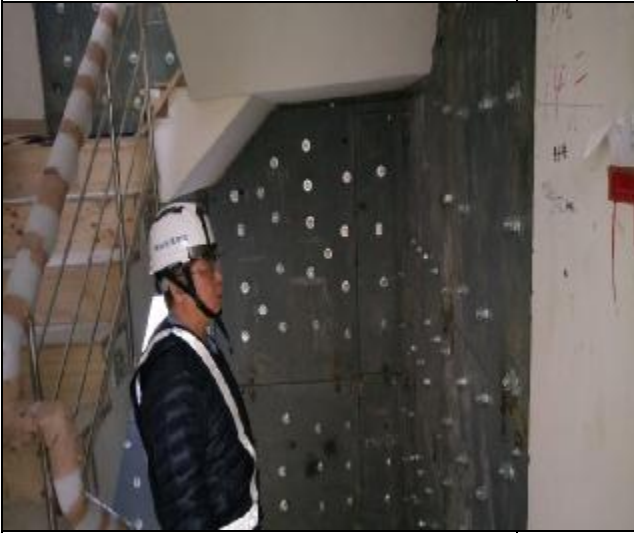
履約管理單位技師抽查 A2 區 F 棟樓梯鋼版補強 1060315
