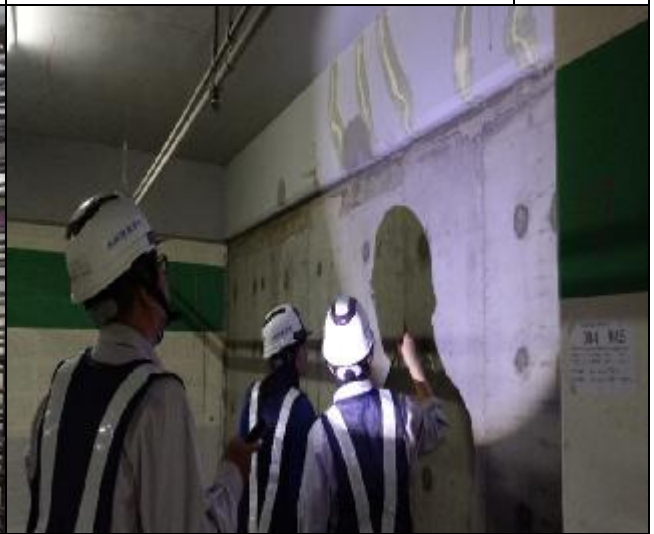
營建署臨時工程督導(A2 區地下室) 1060329
