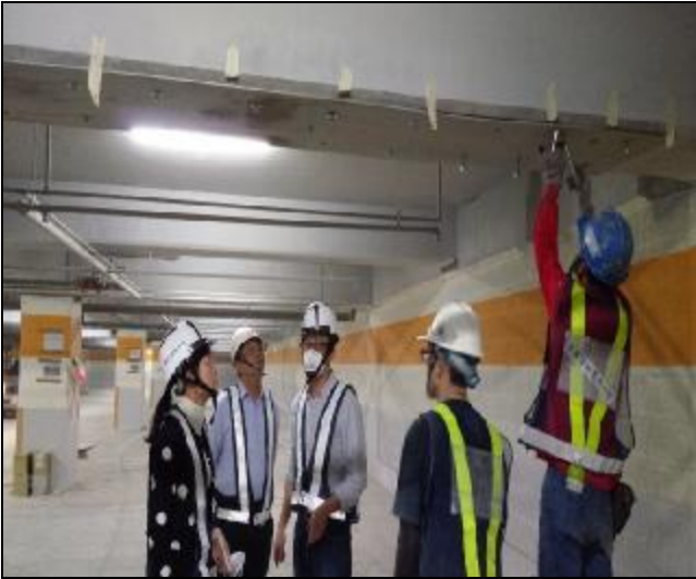
營建署臨時工程督導(A6 西區地下室) 1060324
