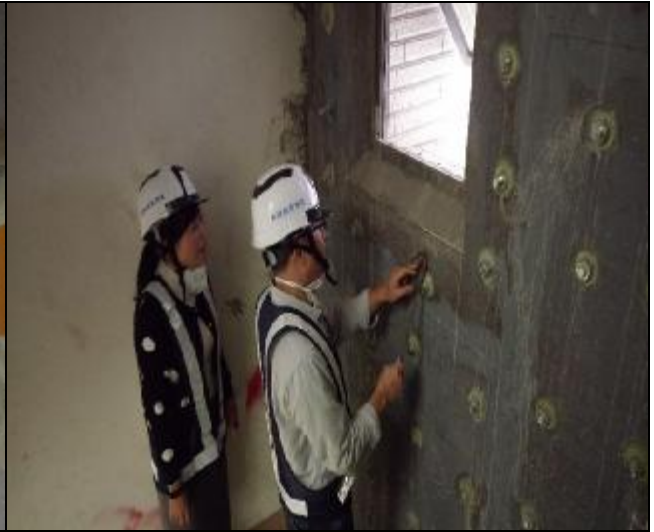
營建署臨時工程督導(A6 西區 M 棟) 1060324
