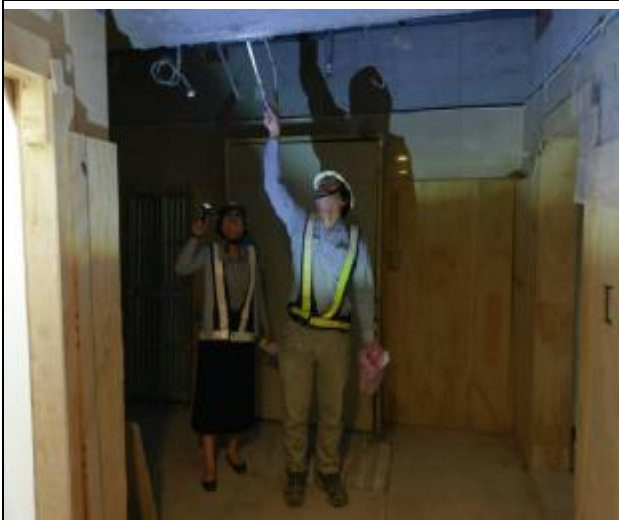
營建署督導 A6 東區 H 棟
