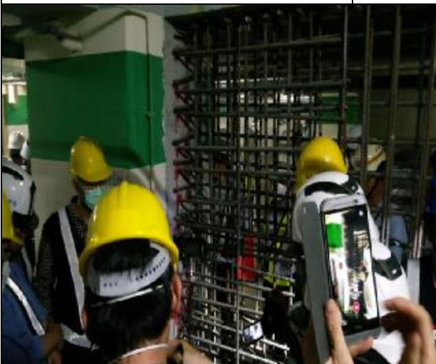
營建署辦理第八次工程查核現場查核
