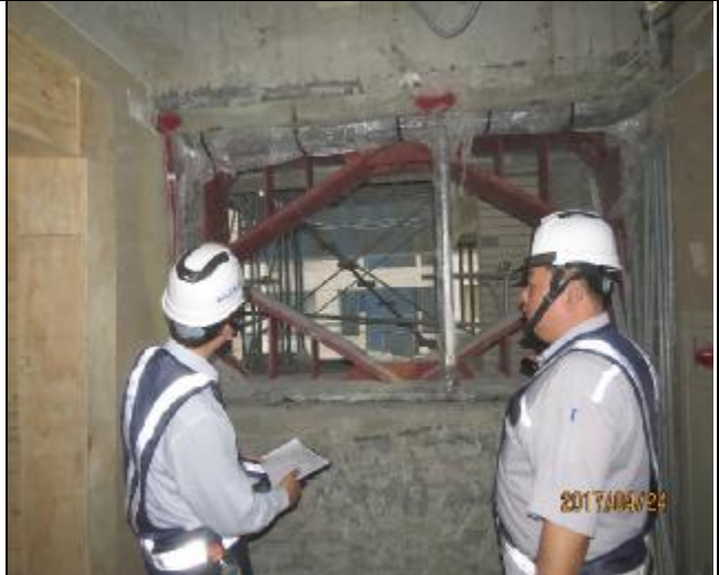
臺億公司督導 A6 東區 A 棟
