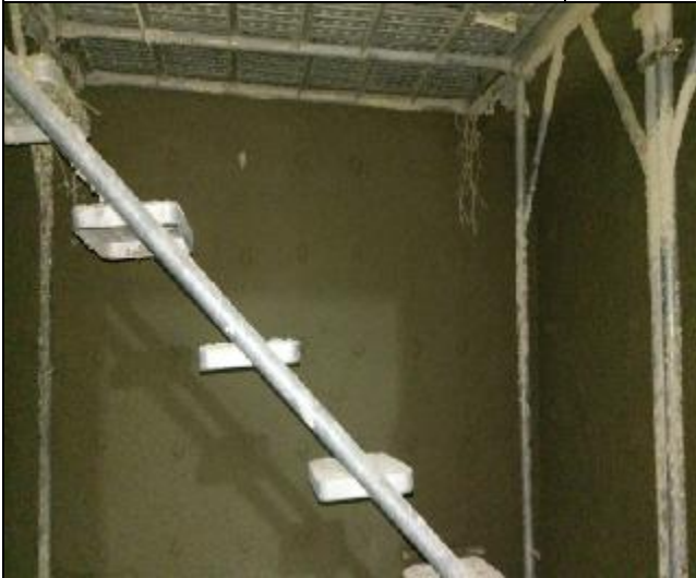
A6 區 E 棟電梯升降道補強完成防火披覆噴塗 1060418
