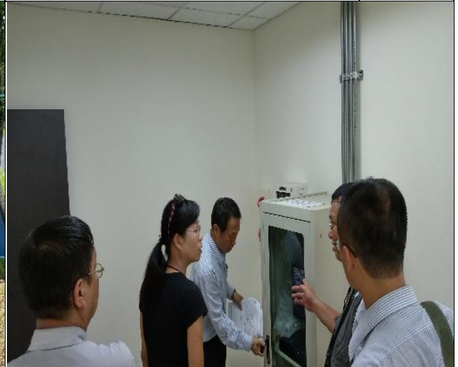
營建署辦理公八公園完工履勘缺失改善施工督導
