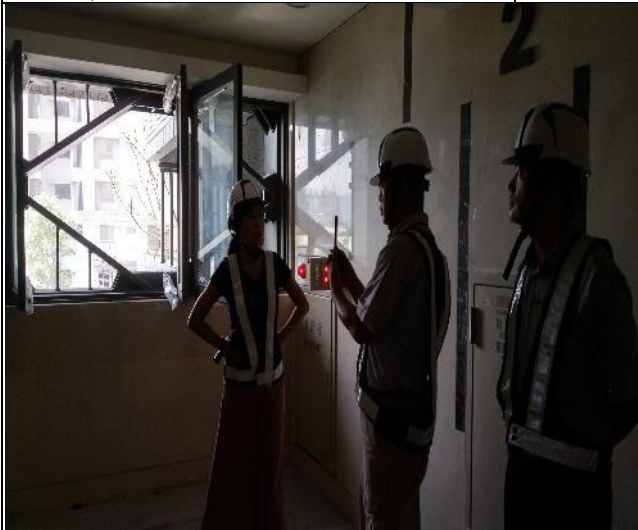
營建署辦理 A2 區 2 樓裝修復原工程督導
