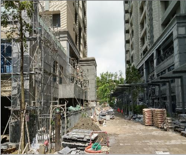
臺億公司辦理 A2 區外牆復原施工督導 1060804
