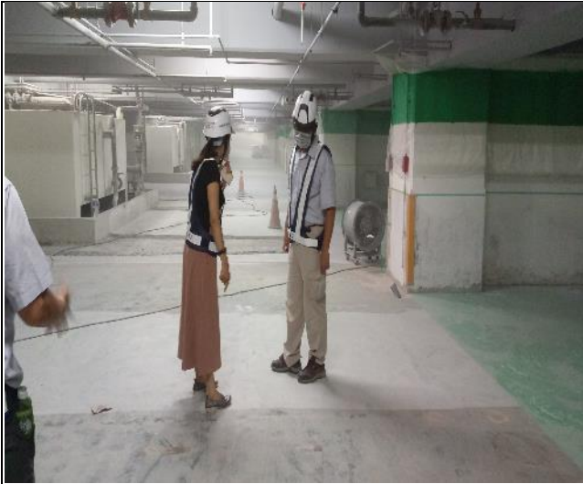
營建署辦理 A2 區地下室裝修復原工程督導
