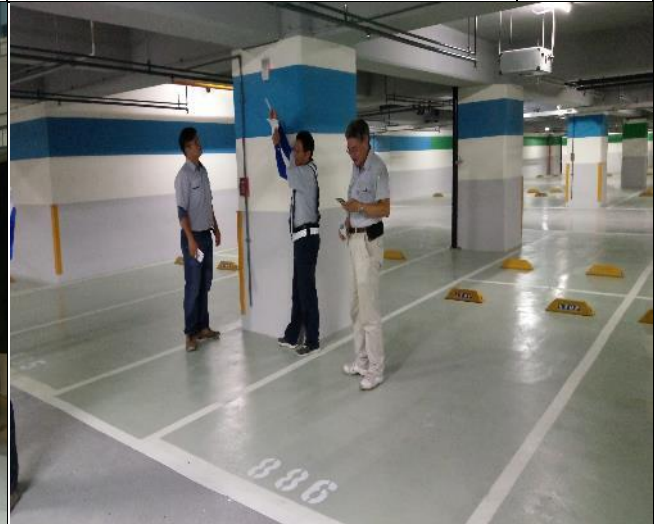
臺億公司辦理 A3 區裝修復原缺失督 導
