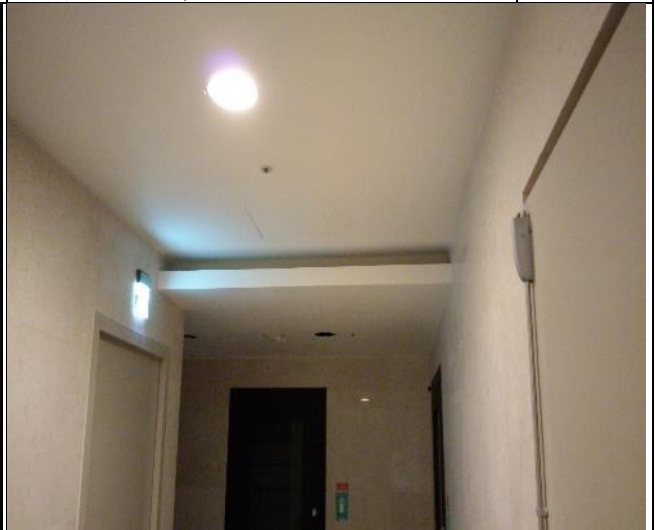
臺億公司辦理 A6 區地上層梯廳天花復原施工督導 1060804
