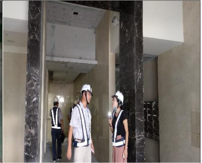
營建署辦理 A2 區 1 樓裝修復原工程督導
