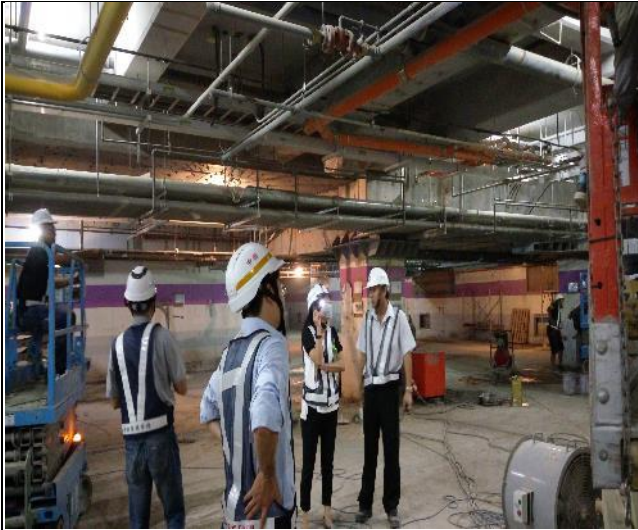
營建署辦理 A6 東西區 1 樓及地下樓結構補強工程竣工查驗
