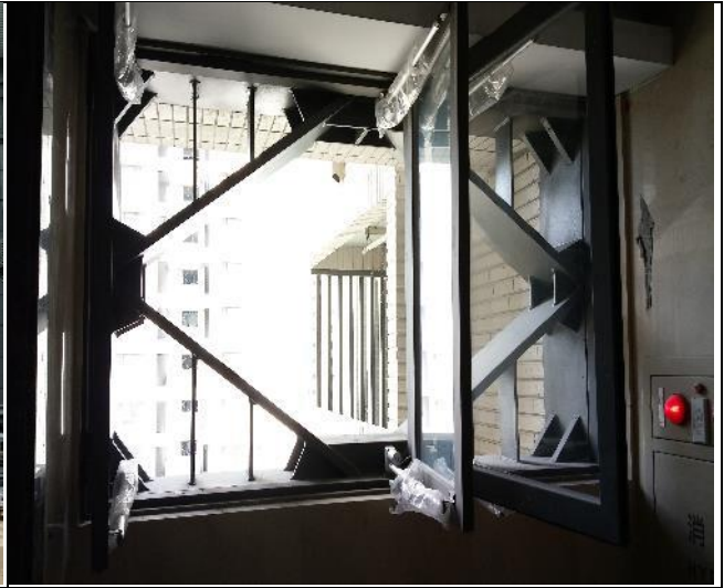
臺億公司辦理 A2 區地上層室內排煙窗復原施工督導 1060804
