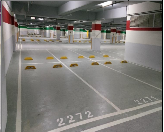
臺億公司辦理 A6 西區地下室 3 樓裝修復原工程督導 1061027
