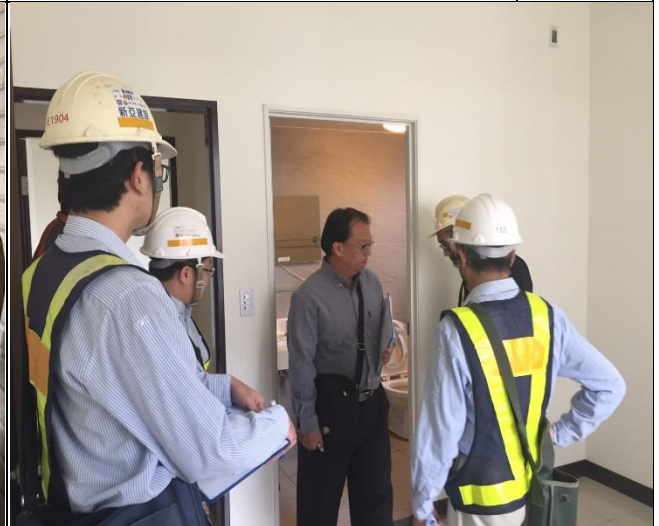
營建署辦理 A6 區完工確認初勘現場會勘
