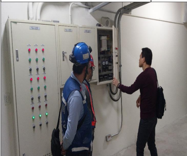
營建署辦理 A6 區完工確認初勘現場會勘
