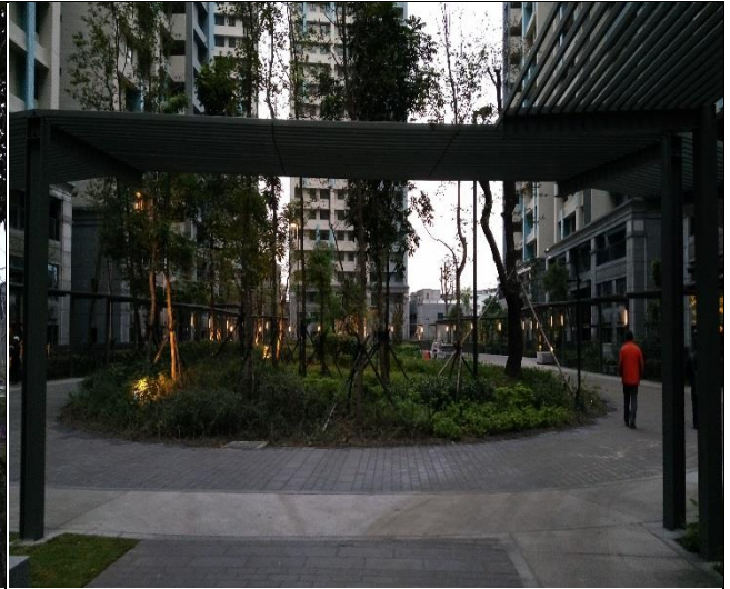
浮洲合宜住宅 A6 區完工現況
