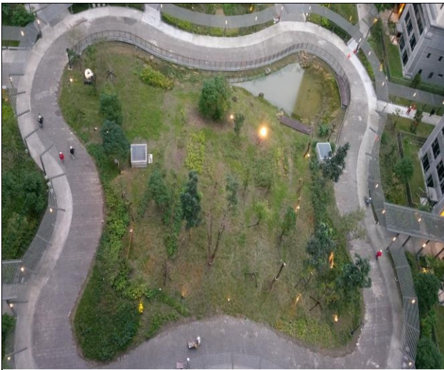
浮洲合宜住宅 A6 東區中庭景觀完工現況
