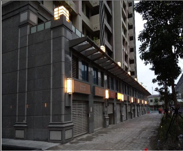
浮洲合宜住宅 A6 區完工現況
