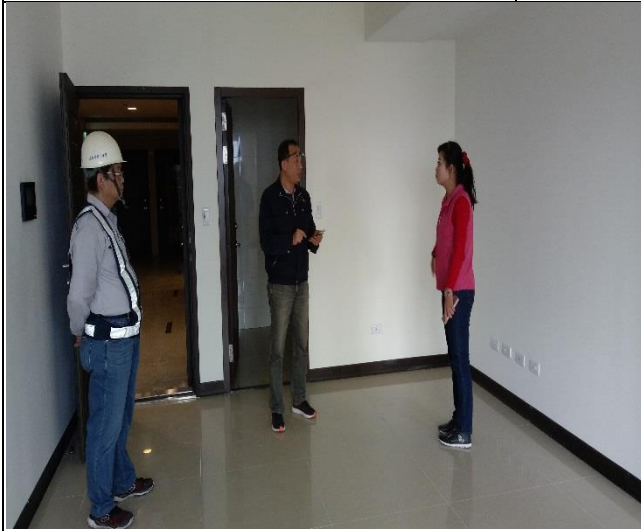
營建署 A6 區完工缺失改善督導
