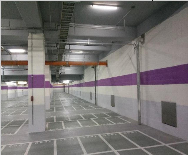
臺億公司辦理監檢測儀器督導-A6 西區桿式變位計安裝完成 1070214
