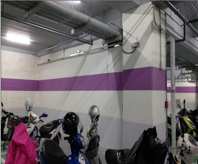
臺億公司辦理監檢測儀器督導-A2 區桿式變位計安裝完成 1070214
