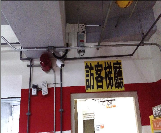
臺億公司辦理監檢測儀器督導-A3 南區資料接收器安裝完成
