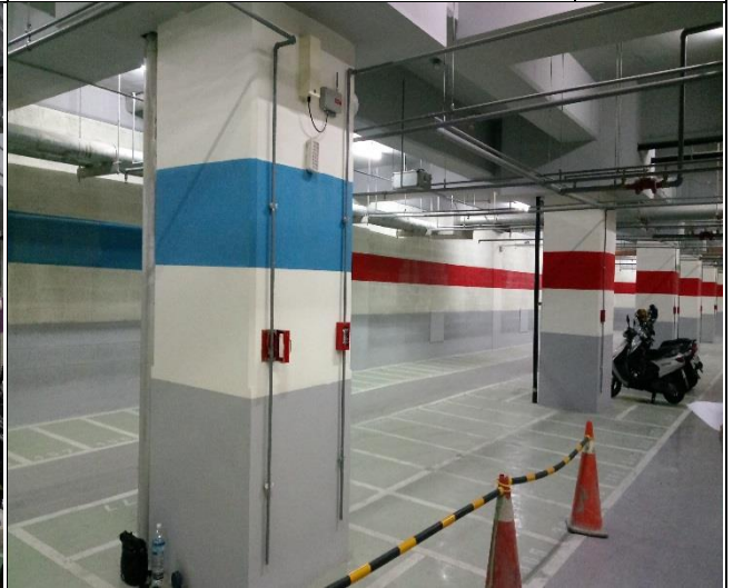
臺億公司辦理監檢測儀器督導-A3 北區電子式傾斜計安裝完成 1070214
