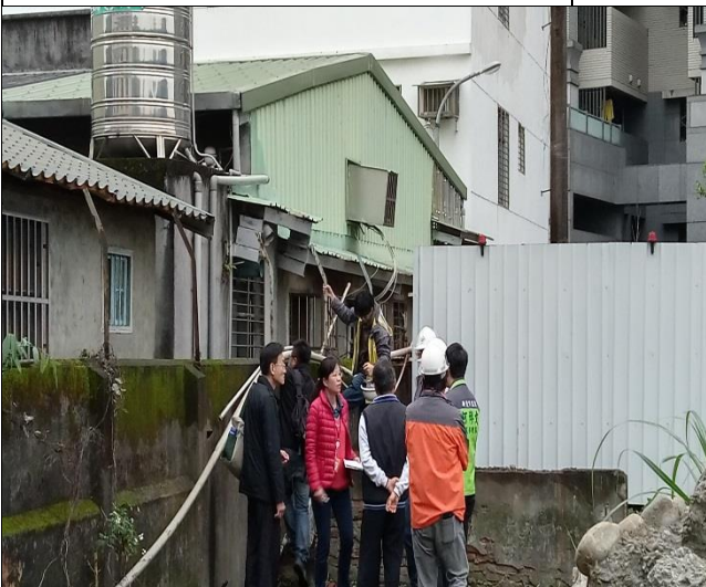
營建署辦理周邊環境排水溝會勘
