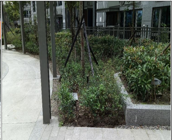
臺億公司辦理 A6 區基地缺失修繕督導 1070307
