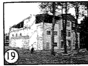
•基地東側建物背面況
