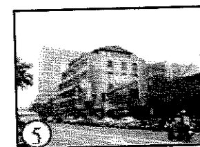
•三重路2-5F建物現況
