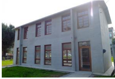
建物修繕後，目前由 NGO 組織經營使用。
