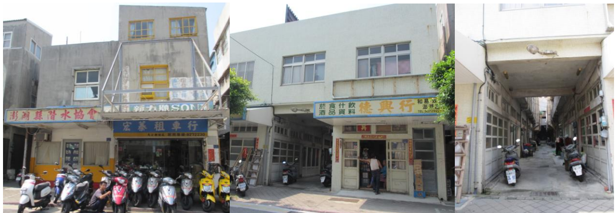
圖 3-16 更新地區沿街面商業使用現況照片
