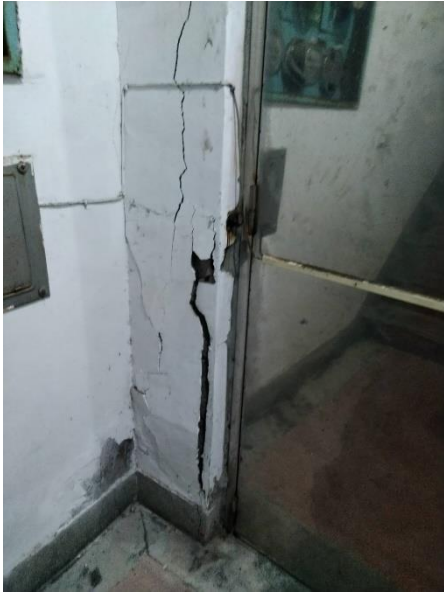
圖7 建物現況照片 (3)
