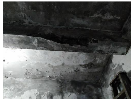
圖6 建物現況照片 (2)
