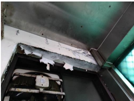
圖5 建物現況照片 (1)
