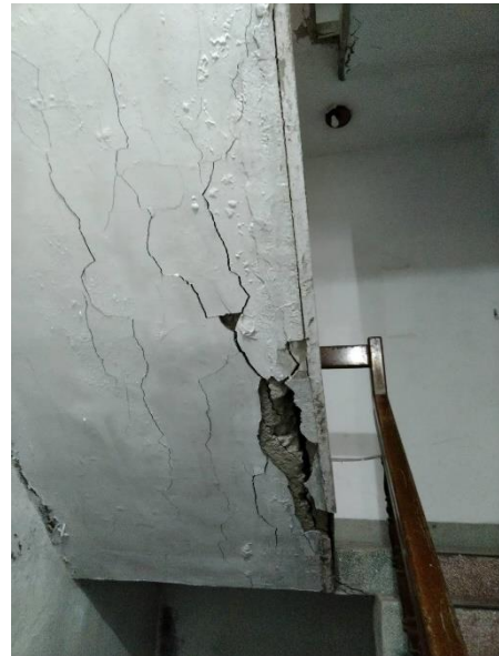
圖10 建物現況照片 (6)
