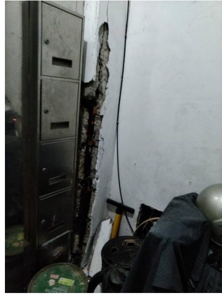
圖8 建物現況照片 (4)
