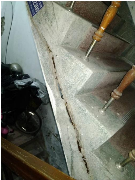
圖9 建物現況照片 (5)
