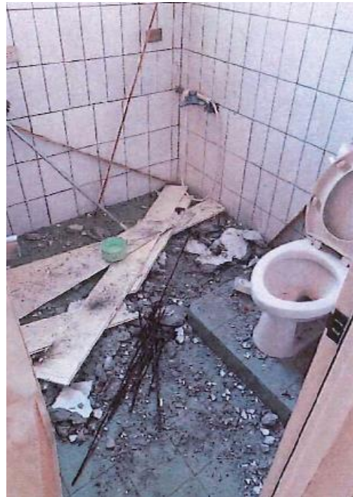
圖12 建物現況照片（2）
