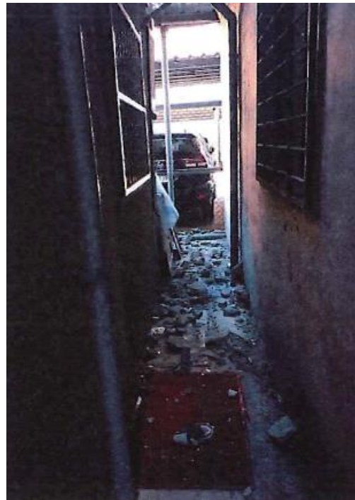
圖16 建物現況照片 (6)
