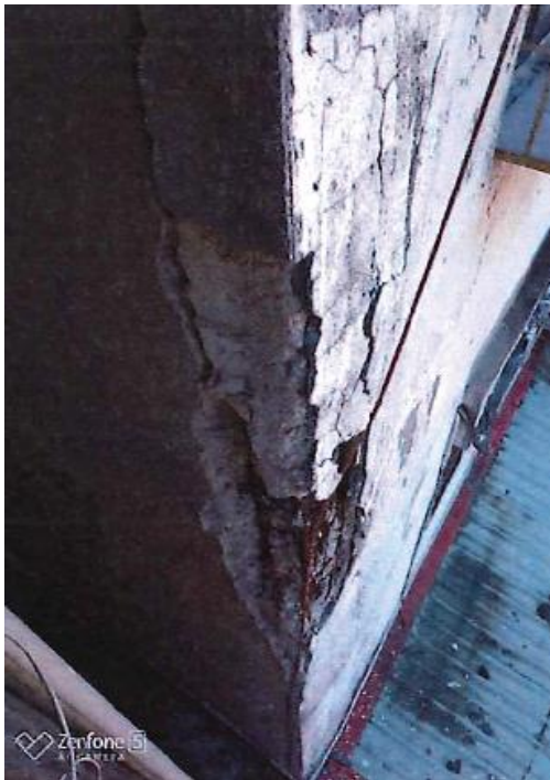
圖15 建物現況照片 (5)
