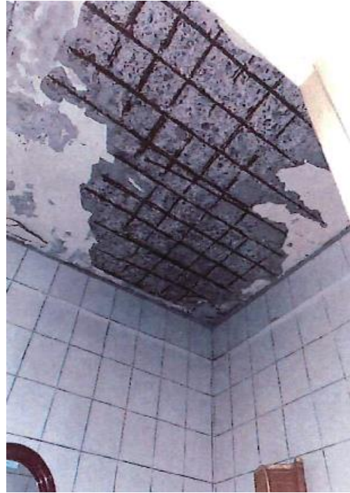
圖14 建物現況照片 (4)
