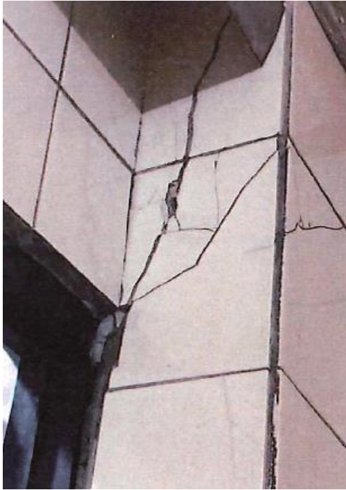
圖13 建物現況照片 (3)
