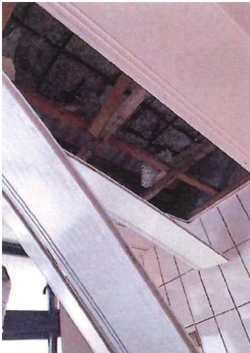
圖11 建物現況照片（1）
