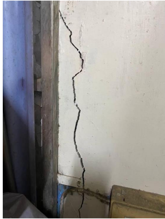
圖16 建物現況照片 (6)
