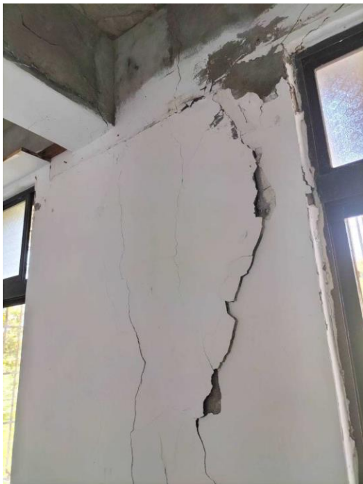
圖11 建物現況照片（1）
