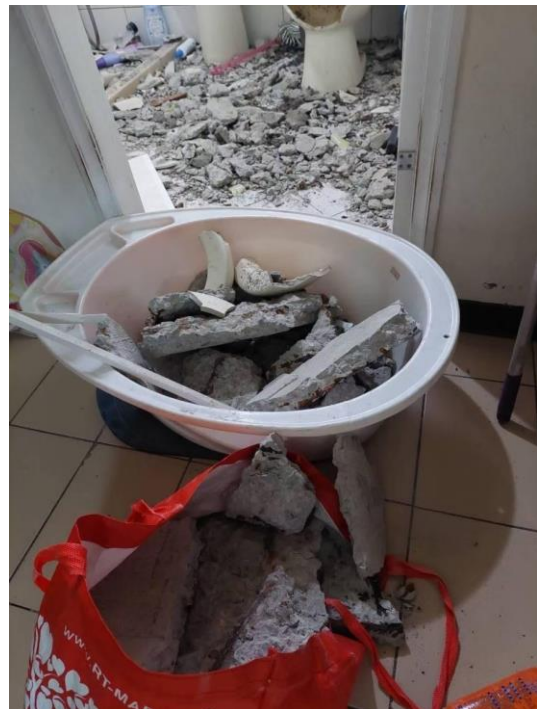
圖12 建物現況照片（2）
