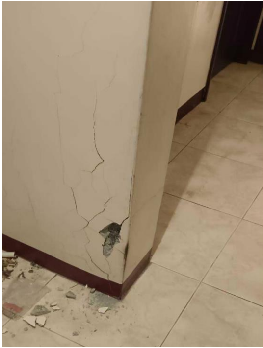
圖15 建物現況照片 (5)
