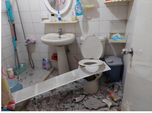
圖13 建物現況照片 (3)
