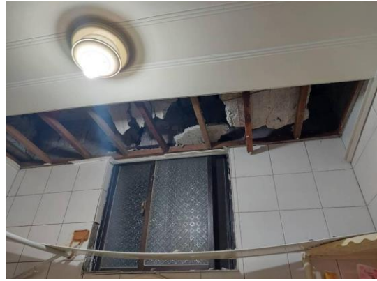
圖14 建物現況照片 (4)
