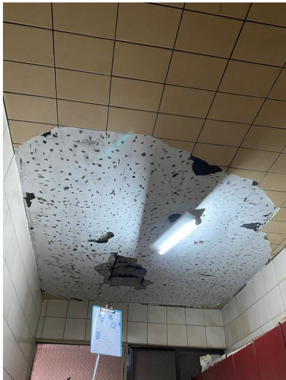
圖 6 建物現況照片(2)
