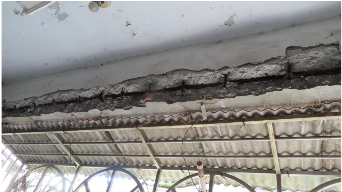
圖 8 建物現況照片(4)
