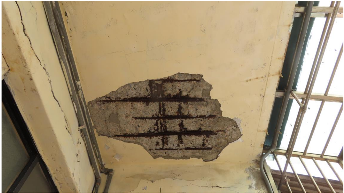
圖 7 建物現況照片(3)
