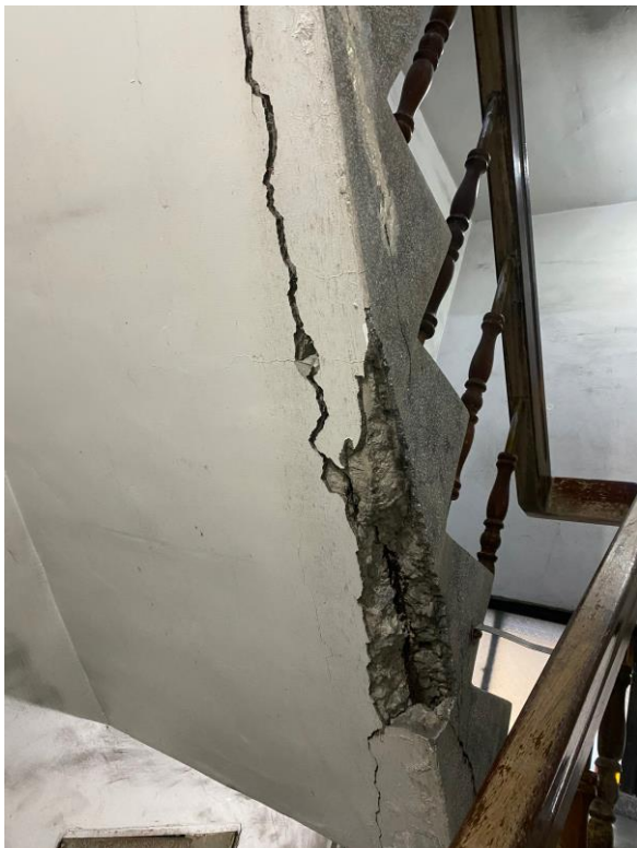
圖 5 建物現況照片(1)
