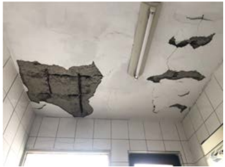
圖 9 室內之現況照片
