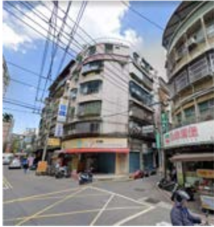
圖 6 建物外觀之現況照片
