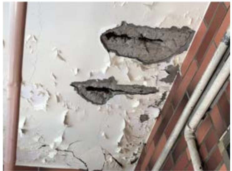
圖 11 室內之現況照片
