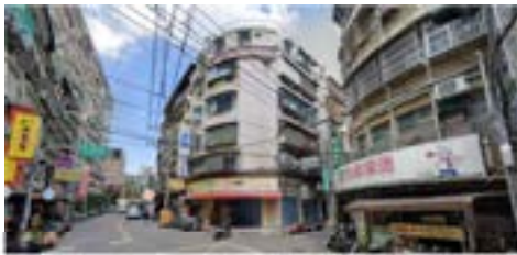
圖 2 建物現況照片(一)
