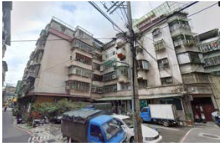
圖 7 建物外觀之現況照片
