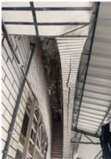
圖 10 室內之現況照片
