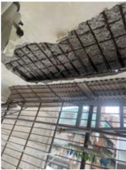
圖 8 室內之現況照片
