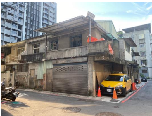
圖7 更新地區範圍內建物現況與結構照片 (3)
