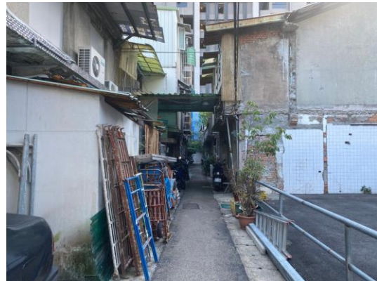
圖6 更新地區範圍內建物現況與結構照片 (2)
