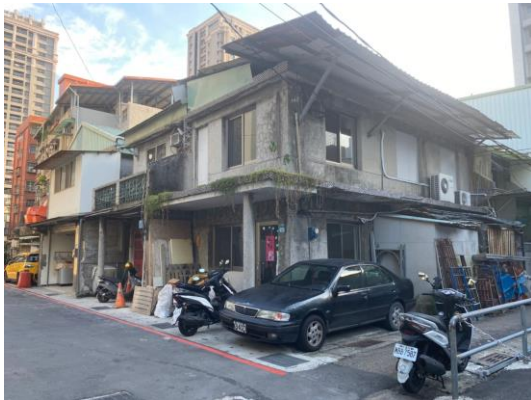
圖5 更新地區範圍內建物現況與結構照片 (1)
