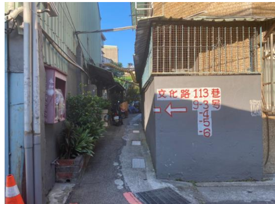
圖8 更新地區範圍內建物現況與結構照片 (4)
