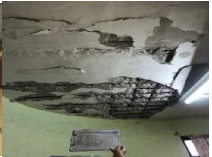
圖13 建物現況照片 (2)
