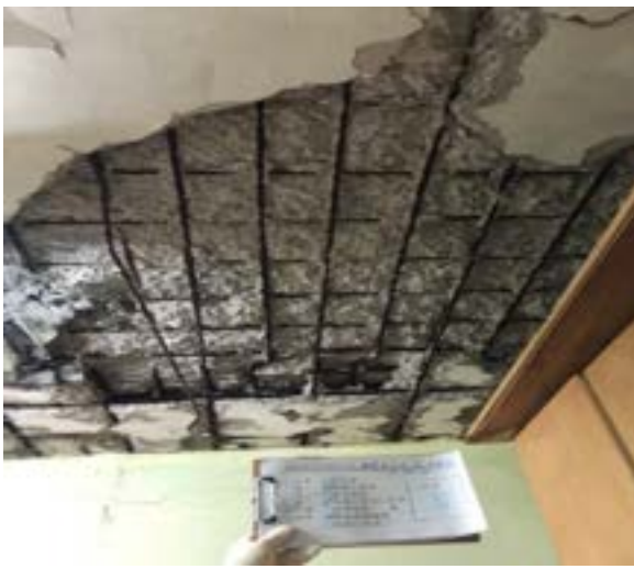
圖12 建物現況照片 (1)
