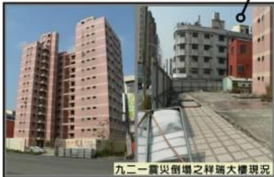
九二一震災倒塌之祥瑞大樓現況
