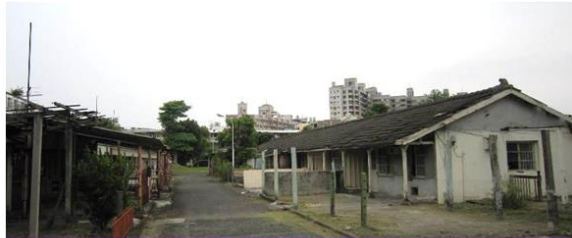
保警宿舍104戶，已拆除
