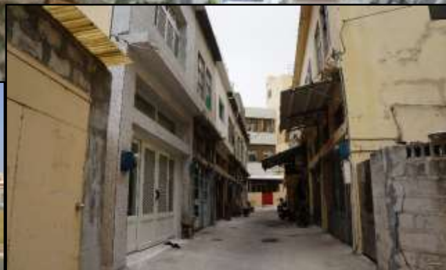
E. 地區內2層樓老舊住宅
