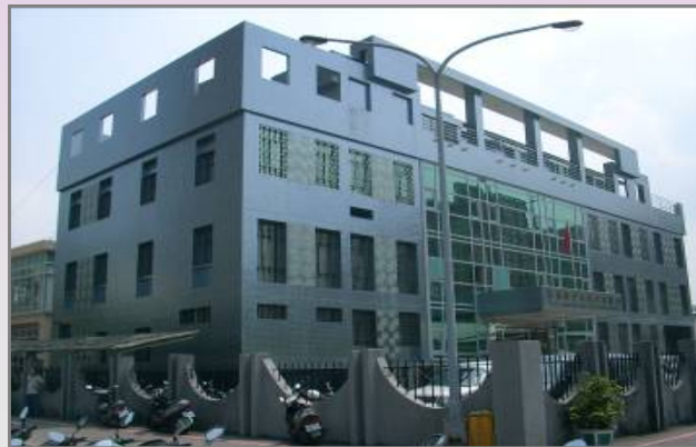
汐止地政事務所外牆整修案
