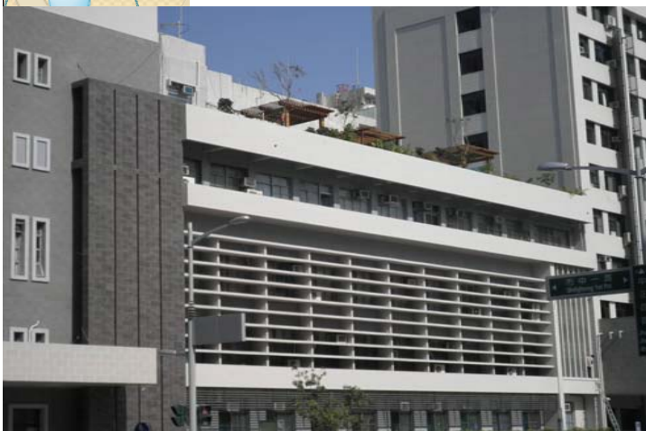
高雄市政府警察局外牆整修案-整修後
