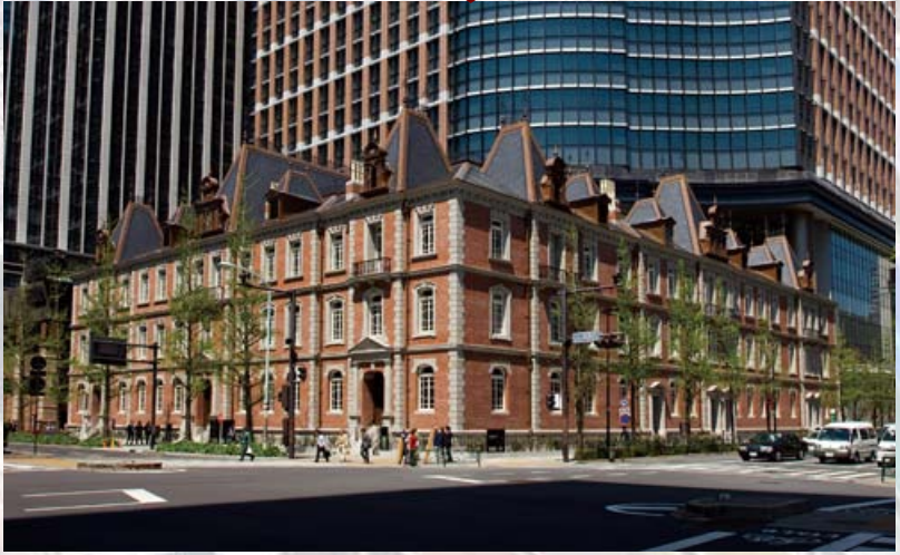
透過當時的設計圖、實測圖、保存部材等儘可能忠實地復元
