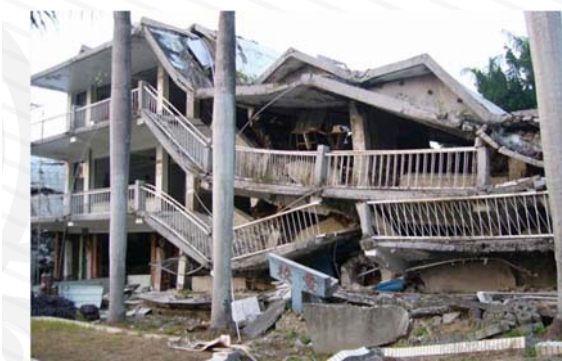
台中市霧峰區 光復國中校舍 (建築物倒塌)
