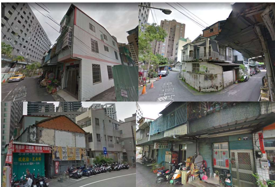
📍 建物現況外觀老舊頹敗，生活品質低落
